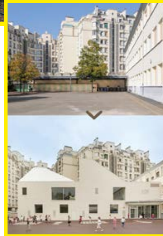
Pôle danse du conservatoire à Rayonnement Régional
